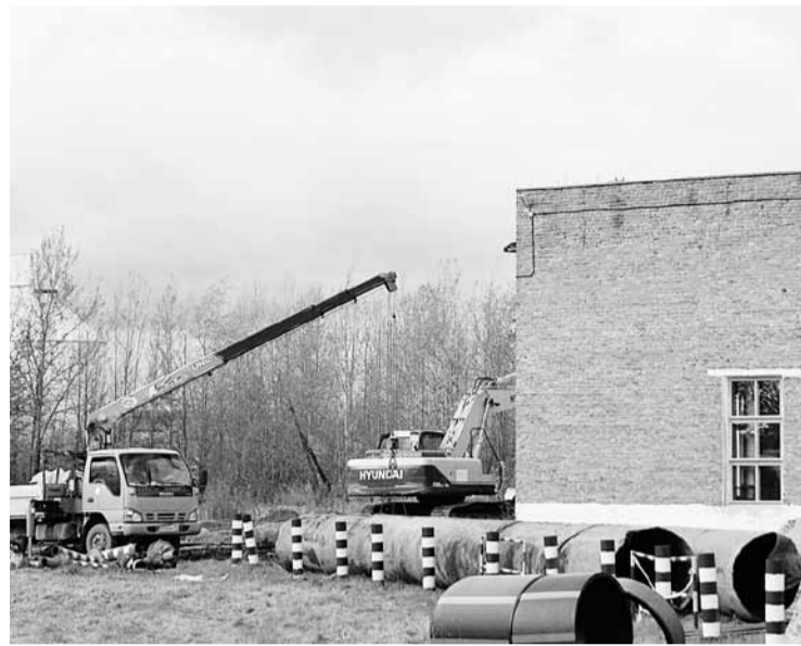
Полным ходом идут работы по замене трубопровода напорного коллектора сточных вод
