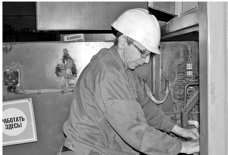
Производится замена вводного автомата секции. Электрослесарь 6 разряда Л.А. Беляков
