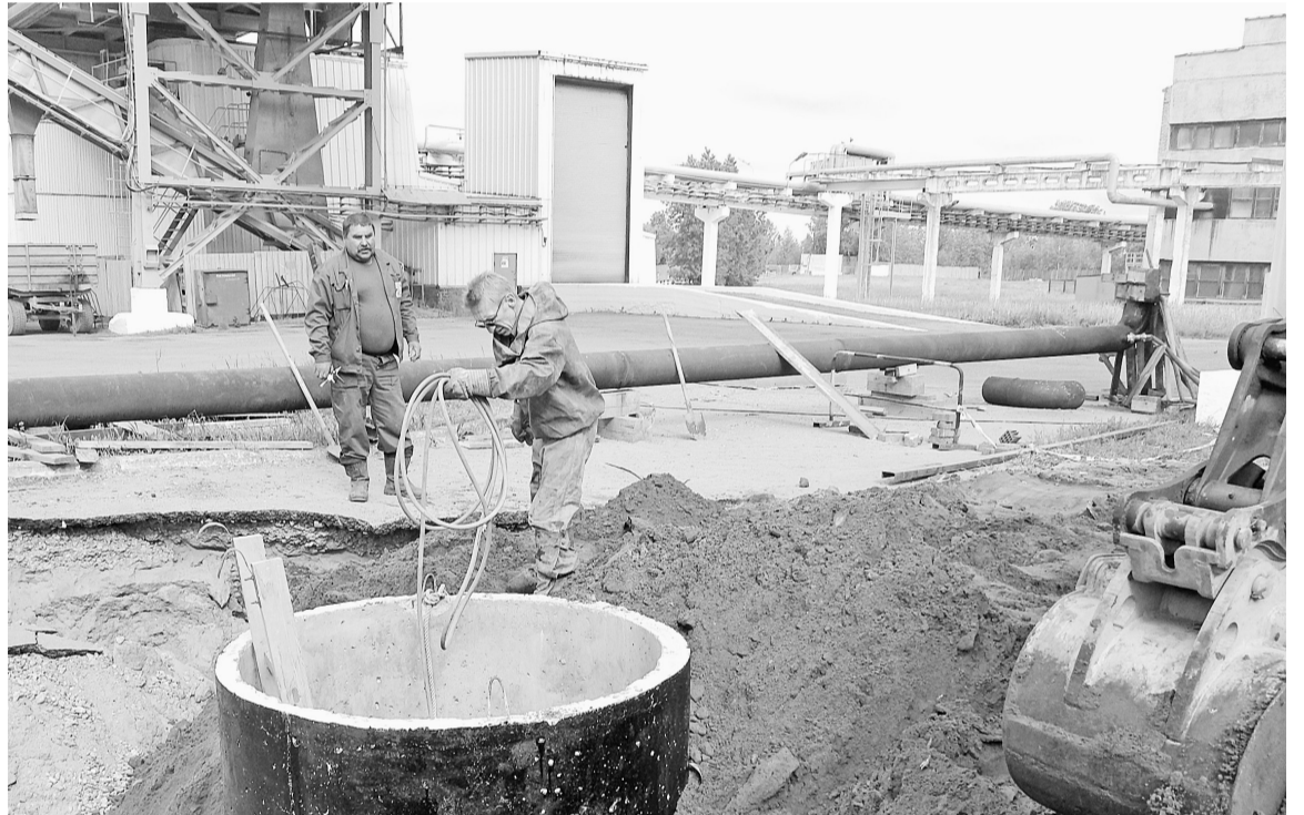
Бригадир слесарей аварийно-восстановительных работ И.В. Мельник и слесарь АВП В.М. Стельмашук готовятся к установке в канализационной трубе пневматической заглушки
