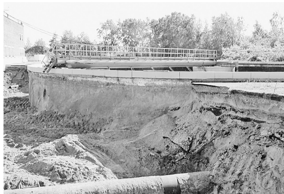
Ремонтные работы на радиальных отстойниках
