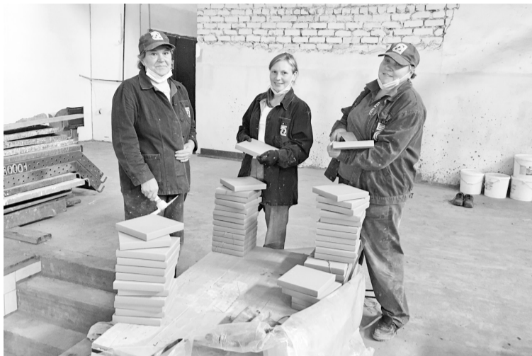
Бригада штукатуров РСЦ
