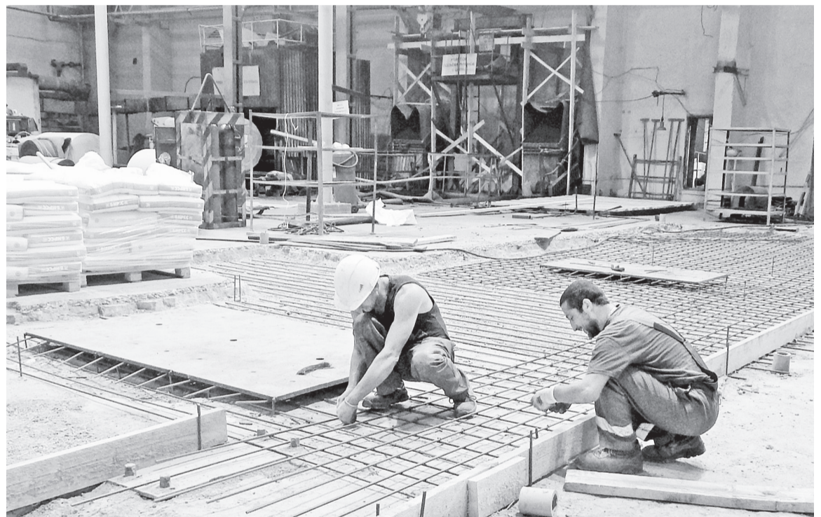
Специалисты РСЦ производят армирование пола в БП № 3
