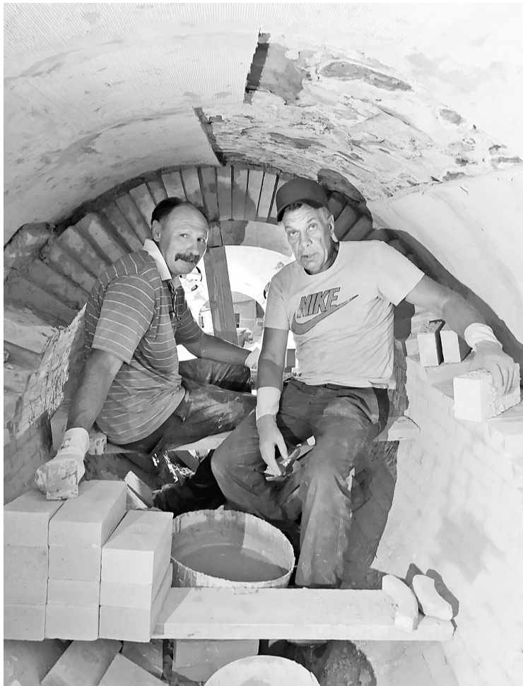
На ремонте печи в КВУ: каменщики А.Н. Шарыгин и С.А. Лобовиков
