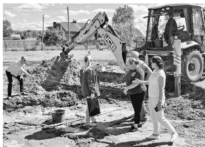
Идёт подготовка площадки под фундамент памятника
