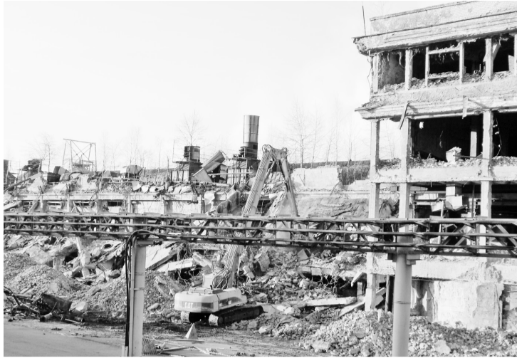
Идёт демонтаж отбельно-сушильного цеха
