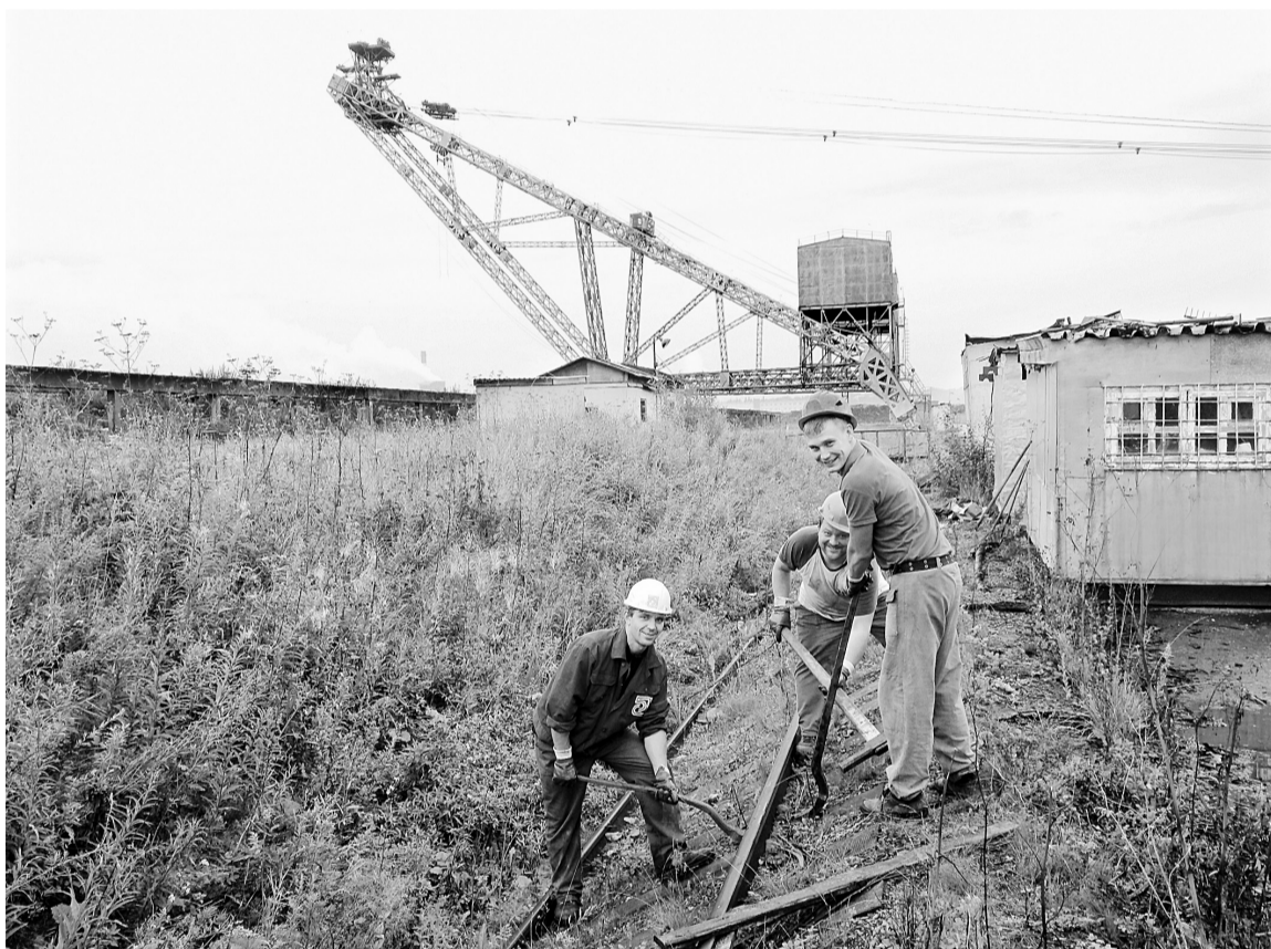
Ремонт подкрановых путей кабель-крана № 6
