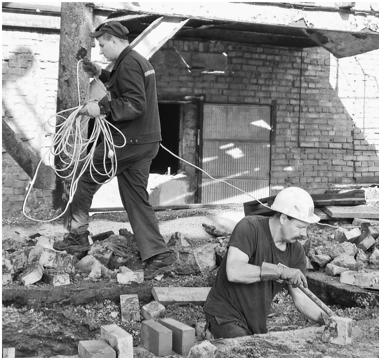
На ремонте колодца каменщик 4-го разряда В.В. Лыткин и каменщик 5-го разряда А.Н. Шарыгин
