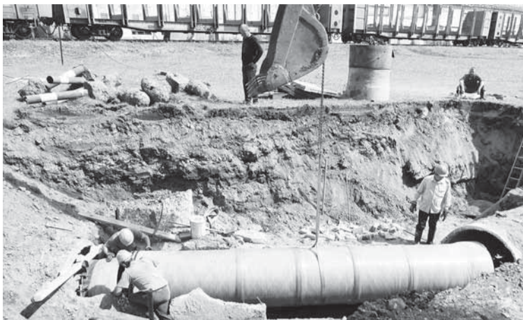
Процесс санации производственной канализации стеклопластиковыми трубами. Работы выполняет ООО «ПМК-214».
