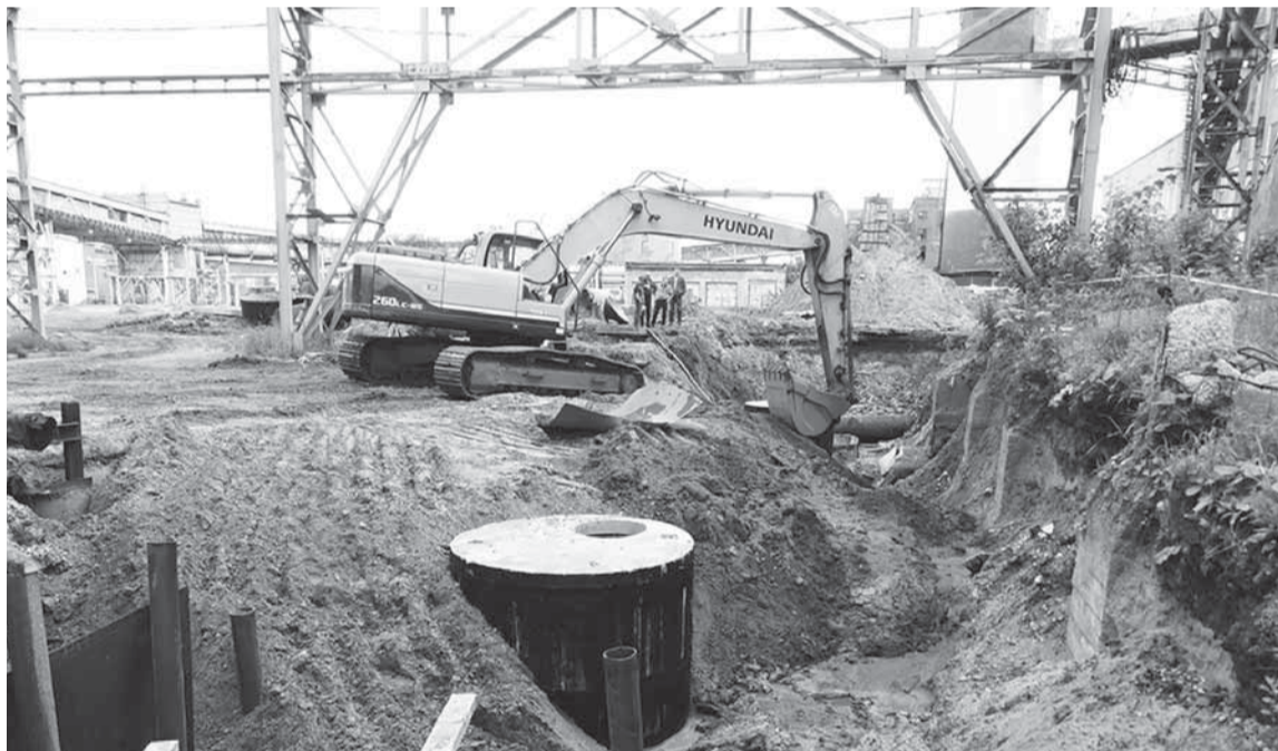
Работы по выносу производственной канализации из зоны реконструкции ТЭЦ выполняет ООО «ВАНТ».
