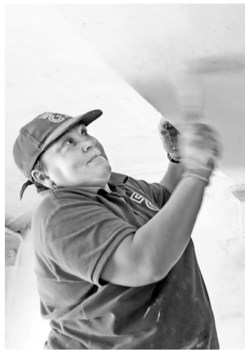
Добавим света! Штукатур 4-го разряда Н.И. Чучулина красит потолок лестничной клетки в БП №2
