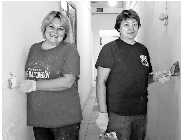
Ремонт в КВУ делают с душой и настроением штукатуры 4-го разряда О.И. Рысева и Т.В. Брейде
