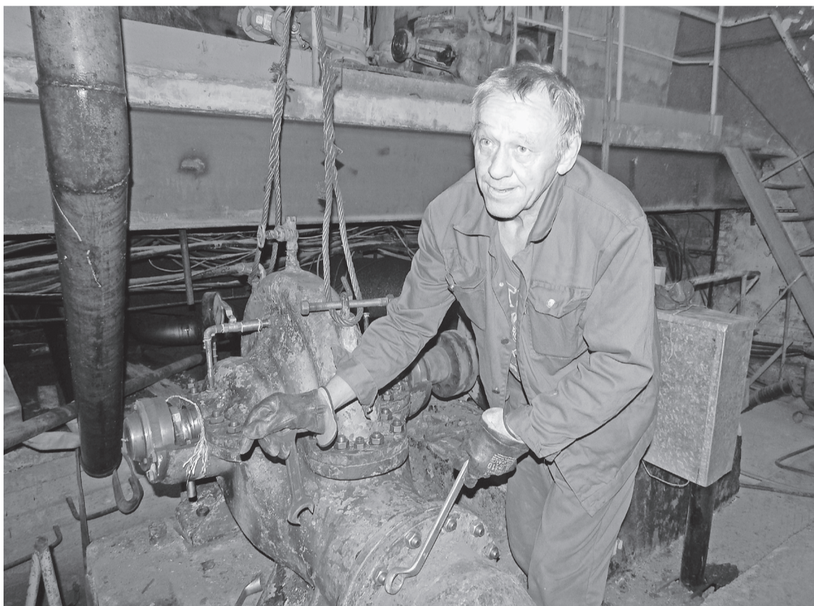
Слесарь-ремонтник цеха водоснабжения С.И. Давыдов за ремонтом насоса насосной станции третьего подъёма
