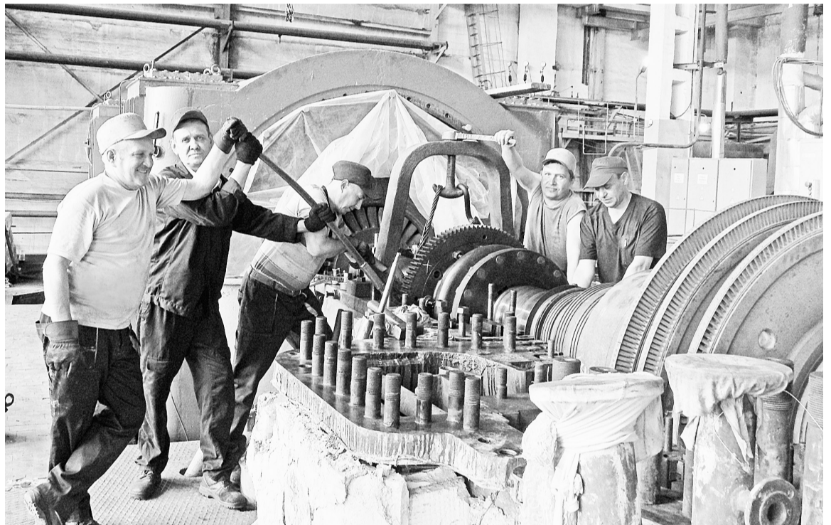
Идёт сборка ротора турбины №7
