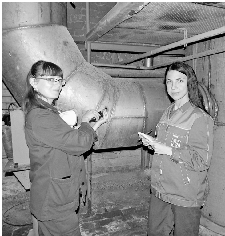
Инструментальные замеры на эффективность очистки промышленных выбросов в целлюлозном производстве. Лаборант по анализу газа и пыли Ю.М. Добрынина (СПЛ) и инженер-технолог О.В. Громова (ООП)
