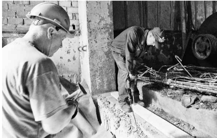
Ремонт ТРА в бумпроизводстве №2 ведёт бригада Е.А. Торопова
