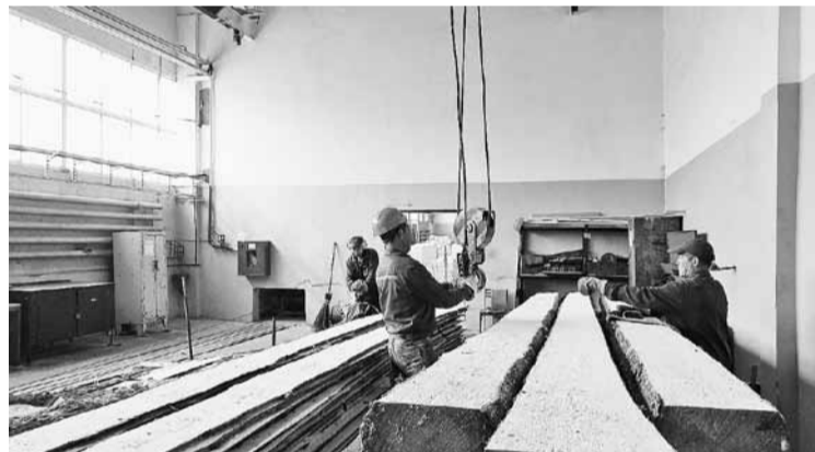
Строповка полубруса. А.В. Гладкий, А.А. Гнутов, А.Л. Запольских
