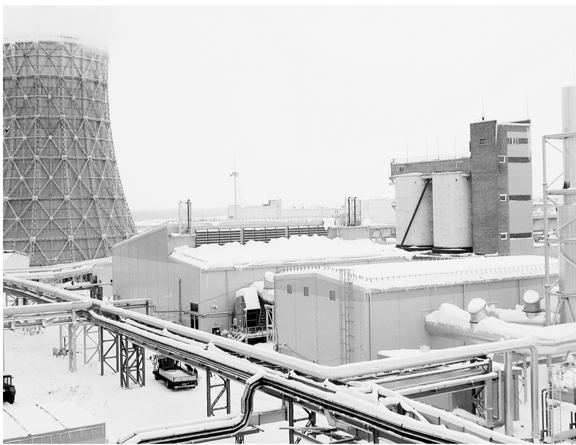
Сегодня все основные здания и сооружения по проекту построены
