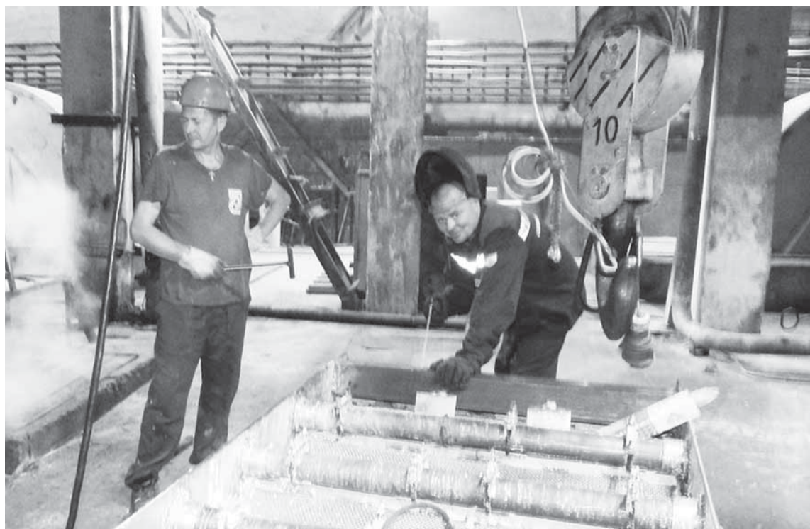
Сварщик ЦЦР Д.В. Черепеников за ремонтом щеполовки.
