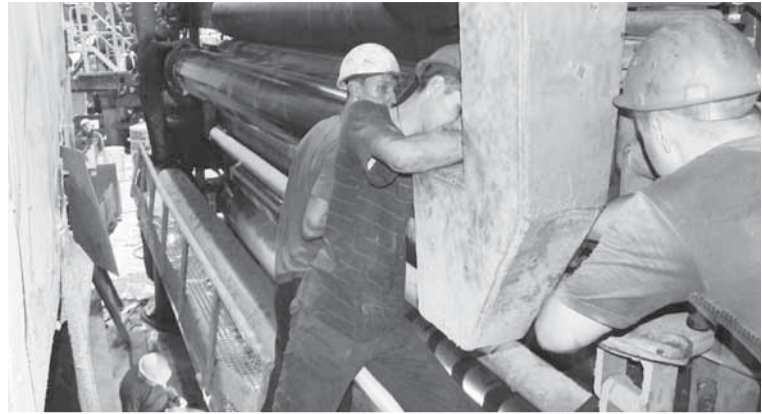
Производится замена каландровой батареи.
