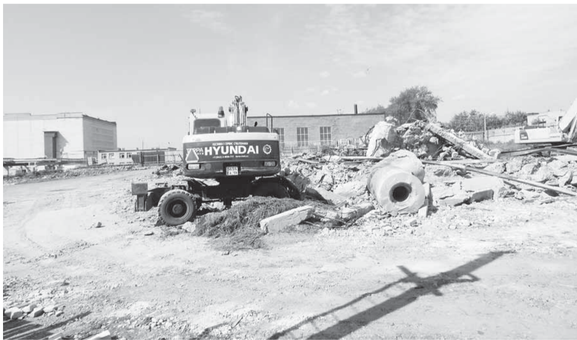
Идут работы на месте будущей парковочной площадки.
