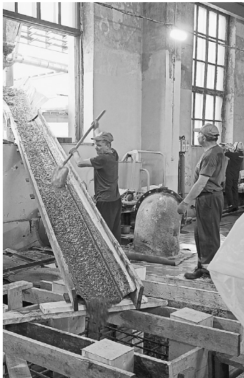
Рабочие заливают фундамент
