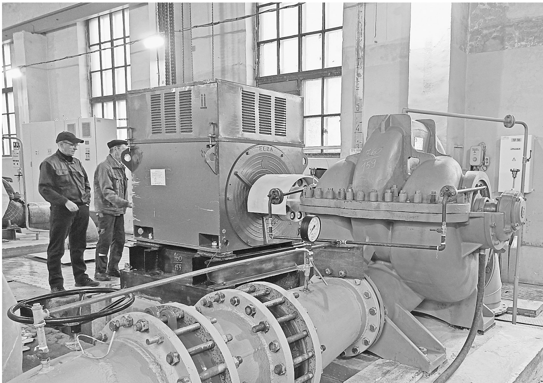
Идёт настройка нового оборудования
