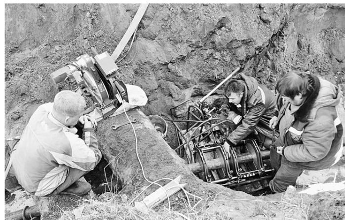
Слесари аварийно-восстановительных работ О.Н. Смирнов, И.В. Торопцев и И.В. Мельник производят в траншее стыковку (сварку) полиэтиленовых труб с помощью специального сварочного аппарата
