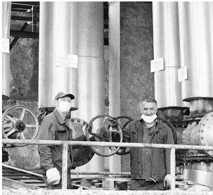
Р.В. Попов, С.К. Зориков — слесари по ремонту оборудования тепловых сетей цеха водоснабжения
