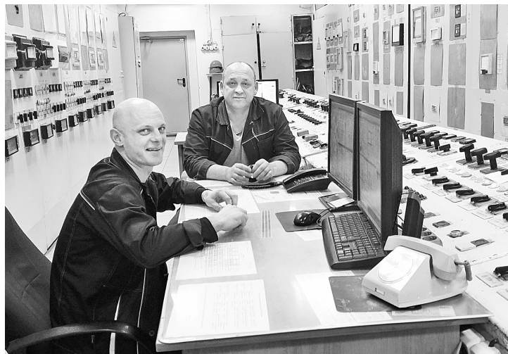
На центральном тепловом щите
