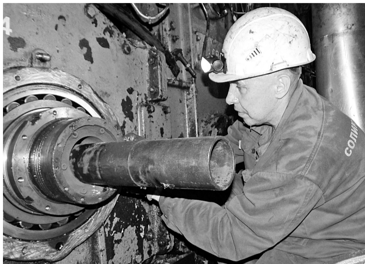
Планово-предупредительный ремонт БДМ № 2. Бригадир Ю.Д. Бутымов
