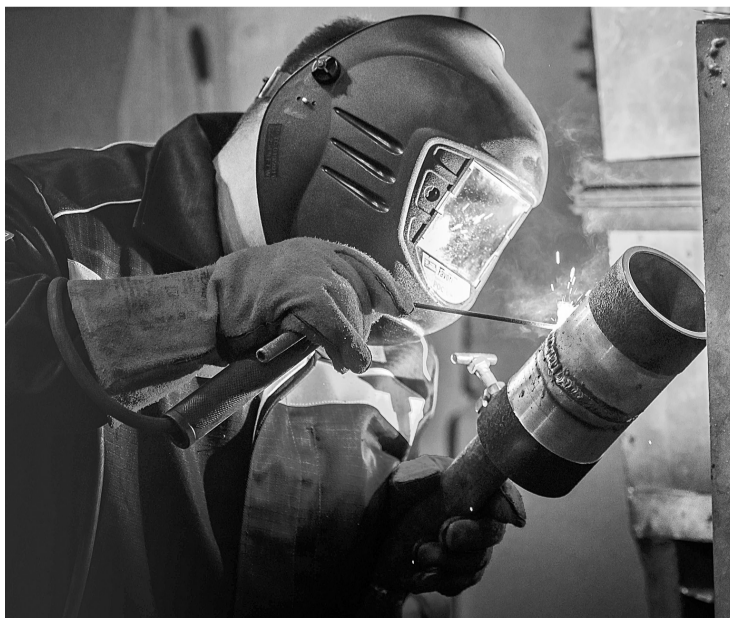
Сварку трубы под углом 45° выполняет Николай Радостев (ЦЦР)
