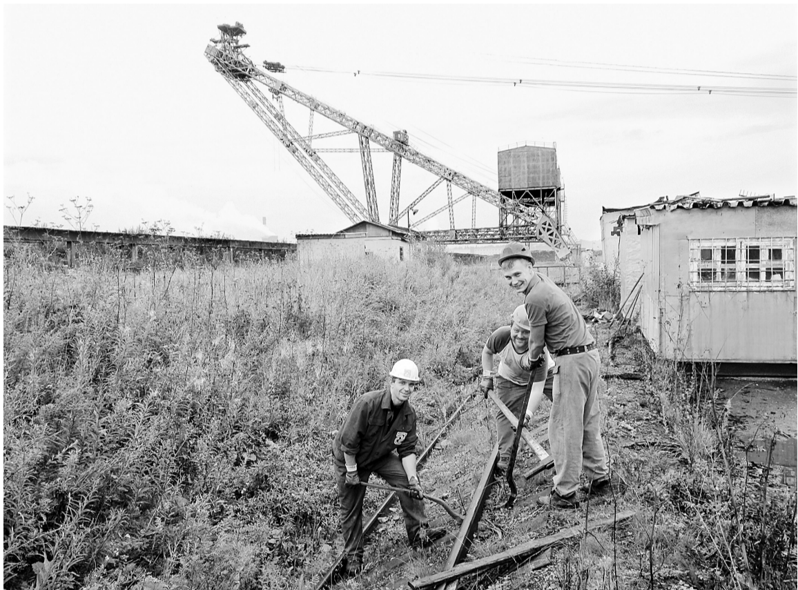
Ремонт подкрановых путей кабель-крана № 6
