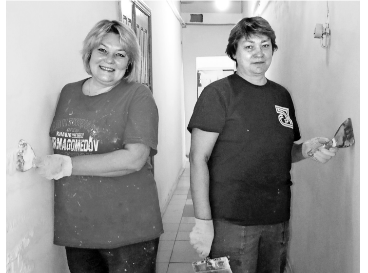
Ремонт в КВУ делают с душой и настроением штукатуры 4-го разряда О.И. Рысева и Т.В. Брейде
