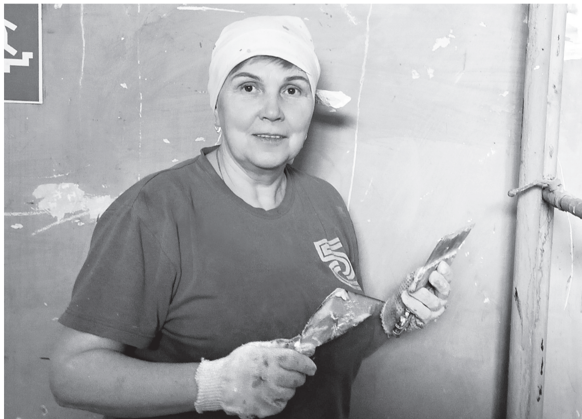
После отделочных работ бумажникам будет приятно ходить по лестнице. Штукатур 5-го разряда Е. В. Серёдкина
