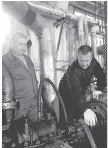
Мазутно-насосный цех. Слесарь-ремонтник Вадим Александрович Кордюков и слесарь по обслуживанию Сергей Иванович Ухов центруют насос второго подъёма.
