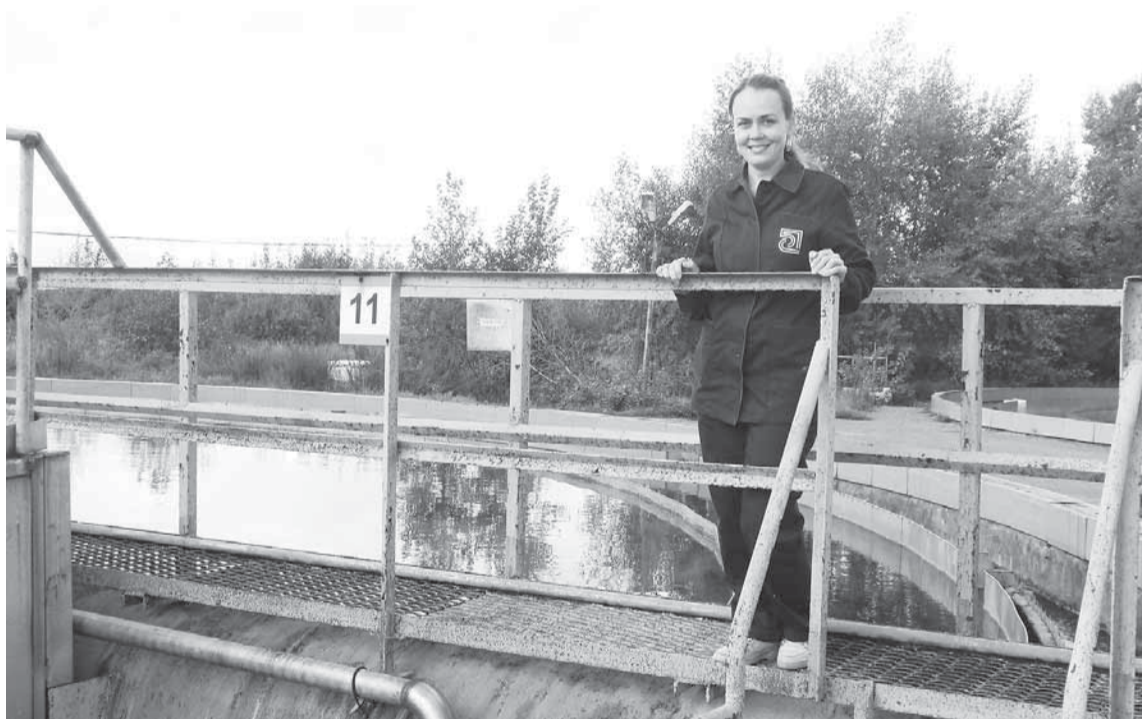
Инженер-технолог цеха очистных сооружений Ю. А. Разорвина во время обхода радиальных отстойников.
