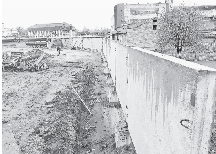
Монтаж железобетонного забора
