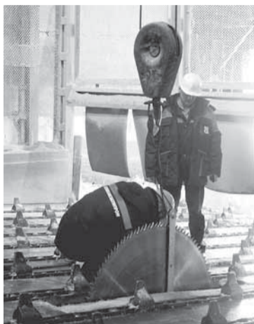
Дефектовка и замена пилы на слешере.
