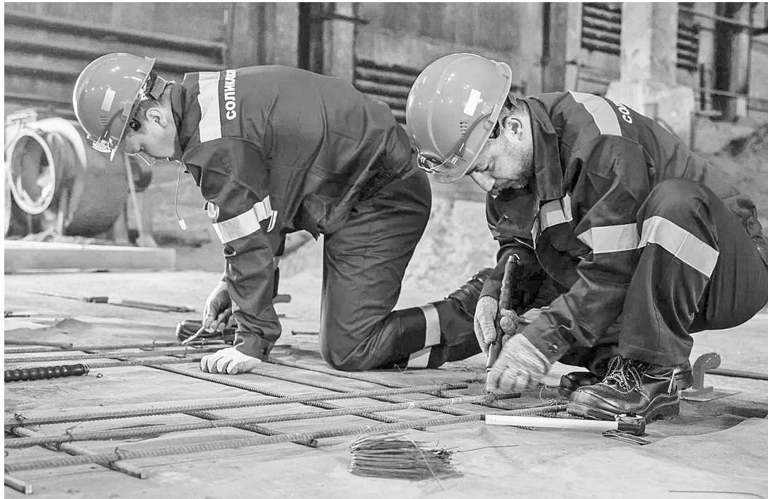
Бетонщики И. О. Семейкин и А. В. Абрамян
