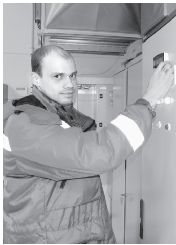
Проверка противопожарных систем ГПС.
