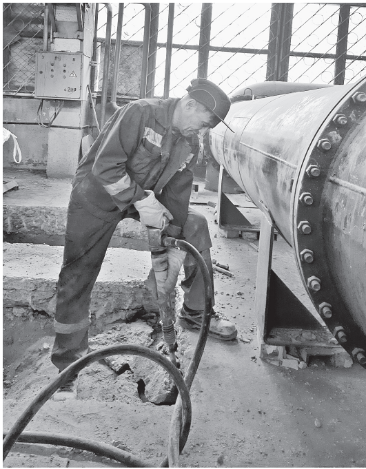
А.А. Гнутов — работа над фундаментом под установку теплообменника
