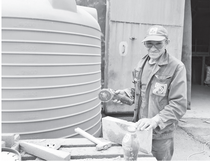
В.А. Мерешко на ремонте печи скруббера
