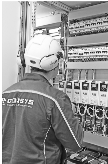
Идёт работа в новом помещении МСС
