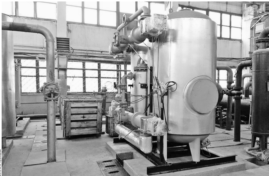
Установленный на фундамент новый осушитель сжатого воздуха ОВН-100 станции осушки №1
