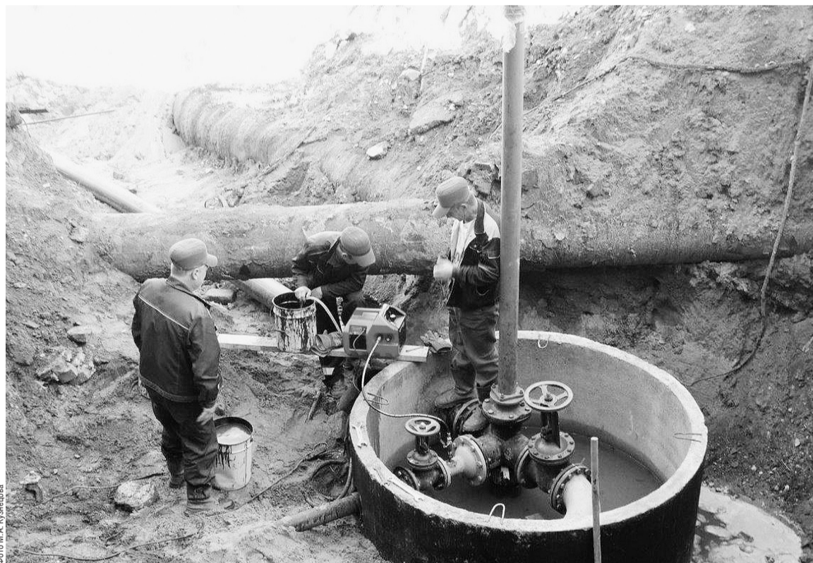
Процесс опрессовки (проверки на герметичность давлением) нового участка линии противопожарного водоснабжения
